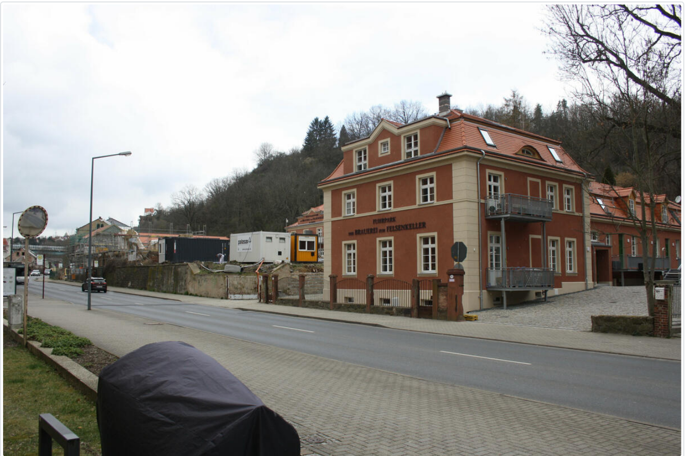
Alter Fuhrpark Felsenkeller mit dem bereits fertig gestellten und bewohnten Teil des Ensembles © Andreas Weihs
