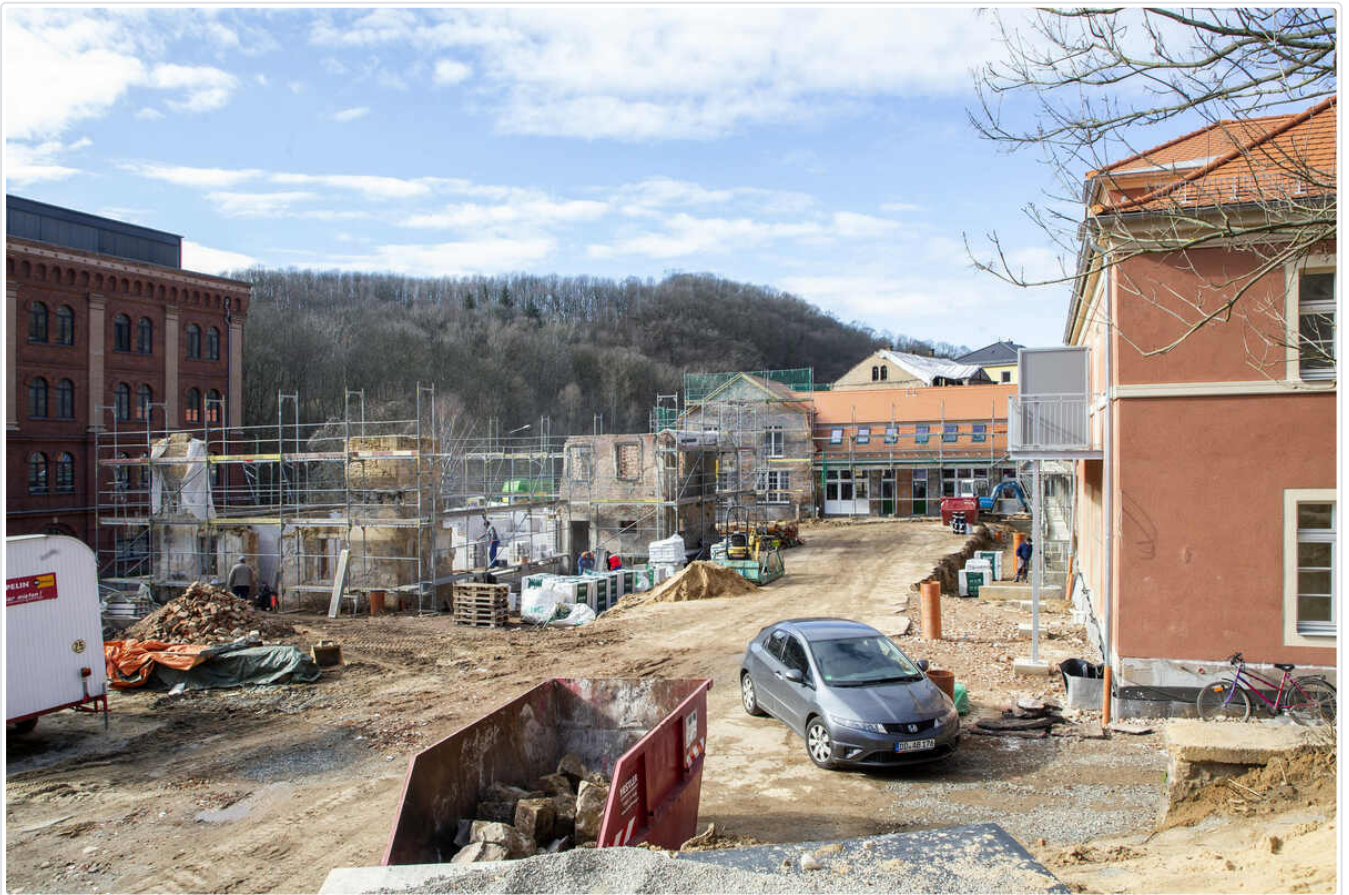
Alter Fuhrpark Felsenkeller, Blick vom Innenhof des Areals © Andreas Weihs
